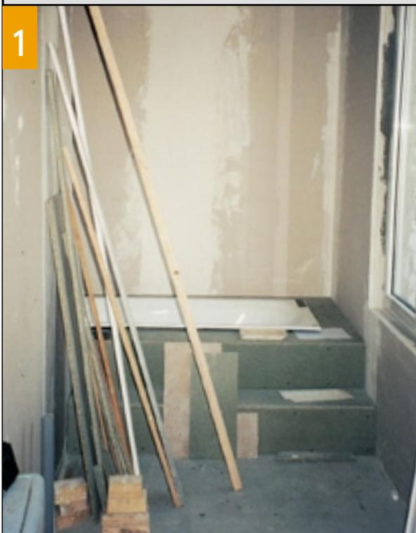
**1.** Encastrée dans son estrade en plaques d'aggloméré hydrofuge, la baignoire est également calée au sol sur des blocs de parpaings scellés, afin de ne pas imposer de surcharge au bâti.
