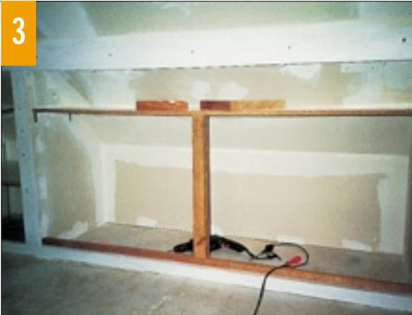
partiment restant. Elle peut être une simple planche de contreplaqué de 8 mm, montée sur charnières, et encadrée dans le cadre. Dans ce cas il faut prévoir une tapée en tasseau de 10 x 20 collée et vissée au montant battant. Elle peut aussi être plus large que le cadre et de même essence.
