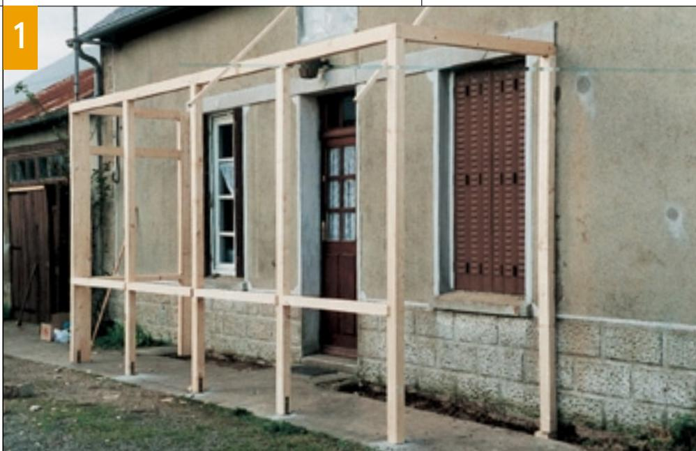
métalliques et vissées dans le bois par deux tire-fond  $\varnothing 8 \times 40$  mm. Les deux poteaux d'adossement sont fixés au mur de façade par des pattes de scellement ou des tire-fond chevillés.
