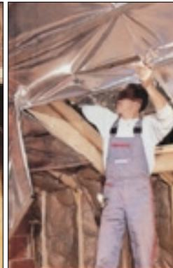
**9.** L'isolant se pose directement entre les chevrons après vissage des suspentes. Il est ensuite recouvert par un film continu, étanche et réfléchissant qui renvoie les calories vers l'intérieur. Des plaques de plâtre seront ensuite posées pour le doublage.
