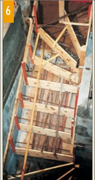
**6.** L'étude de la volée est facilitée par les deux quarts tournants de l'escalier. La hauteur des marches en béton est déterminée avec une réserve de 3,5 cm, pour la pose du carrelage de finition.
