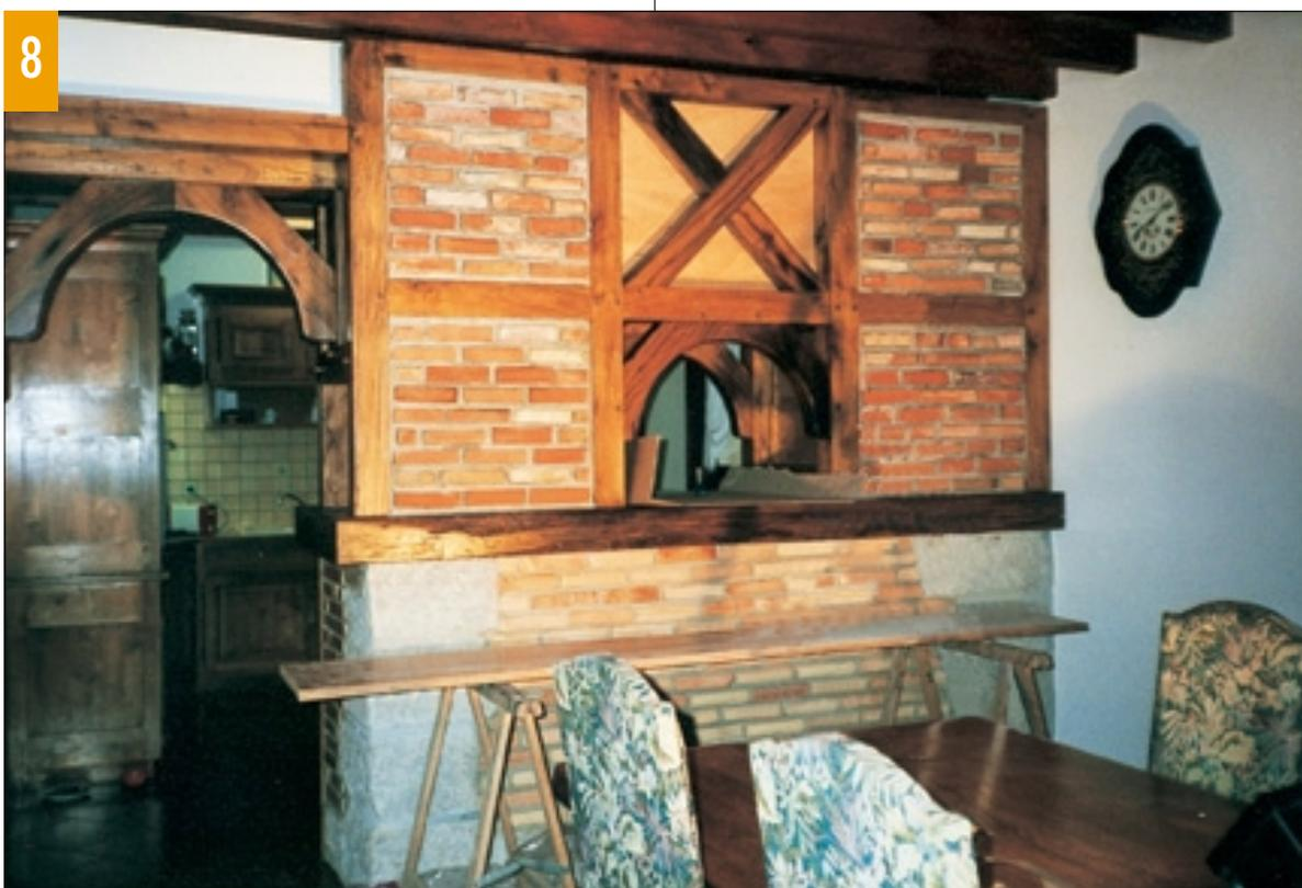
**8.** Le remplissage de briques s'effectue à joints décalés. Des petites cales en carrelé de 10 x 10 ont servi à régler leur épaisseur.
