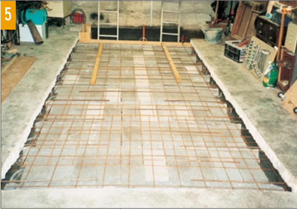
**5. Armé et isolé par un doublage en polystyrène, le plafond de la cave est délimité par un coffrage au niveau de la cage d'escalier. Avant coulage, les différents tubes sont glissés sous la chape existante.**
