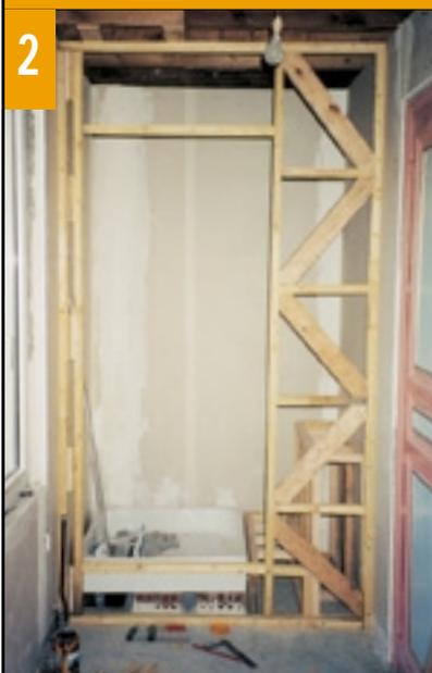
d'aggloméré hydrofuge. Une marche de bonnes dimensions, facilitera l'accès à l'intérieur. L'évacuation et un mitigeur bain-douche sont raccordés aux tuyaux en attente, tandis qu'une trappe de visite est ménagée dans la partie basse du tablier de baignoire.
