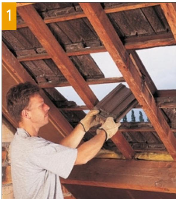
**P**ince à décoffrer, tenailles, scie égoïne, équerre, marteau, tournevis et escabeau devraient suffire pour cette installation. Prévoyez également une bâche de protection, au cas où le temps deviendrait menaçant. De même, les dimensions de la nouvelle menuiserie nécessiteront peut-être une assistance : essentiellement pour emboîter le châssis, une fois le dormant posé.
