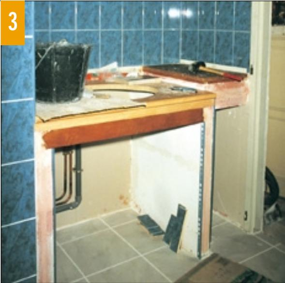
teuse selon la forme de la vasque (avec le gabarit fourni) et les canalisations sont implantées. Le lavabo n'est posé qu'une fois toutes les finitions réalisées, afin de le préserver des traces de colle à carrelage.
