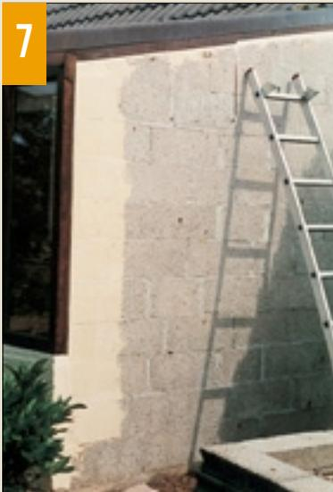
**7.** Avant de "crépir" les murs, un adhésif est collé pour protéger les bordures des boiseries. Le crépi est d'abord taloché sur les bordures. L'adhésif est retiré avant le séchage de la deuxième couche.
