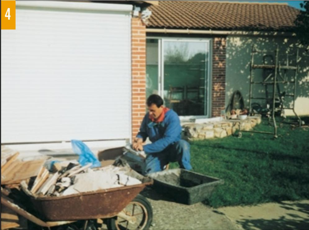
**4. Les joints entre les briques sont remplis au mortier blanc. Ils sont serrés au fer de 12 mm et lissés à l'éponge. Sur le devant des ouvertures est maçonné un seuil incliné en mortier hydrofugé.**
