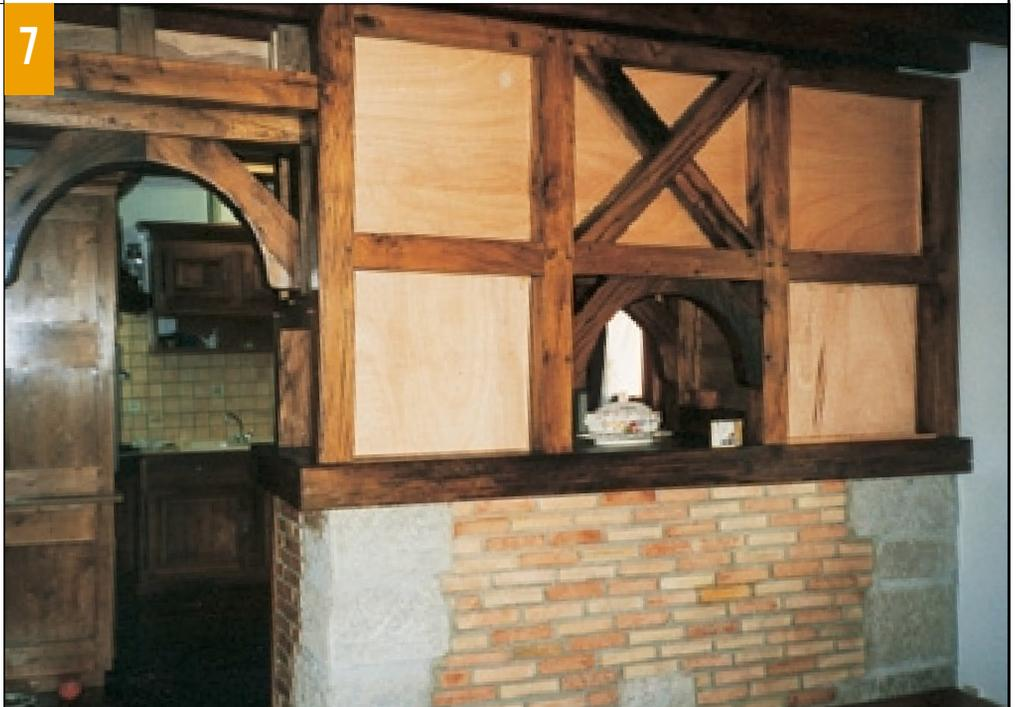
chêne clair. Les panneaux de contreplaqué en contact avec le mortier doivent être traités. Quelques jours après leur édification, les briques sont passées à la brosse métallique. Elles sont alors imperméabilisées à l'aide d'un produit spécifique, puis recouvertes de deux couches de vernis incolore.
