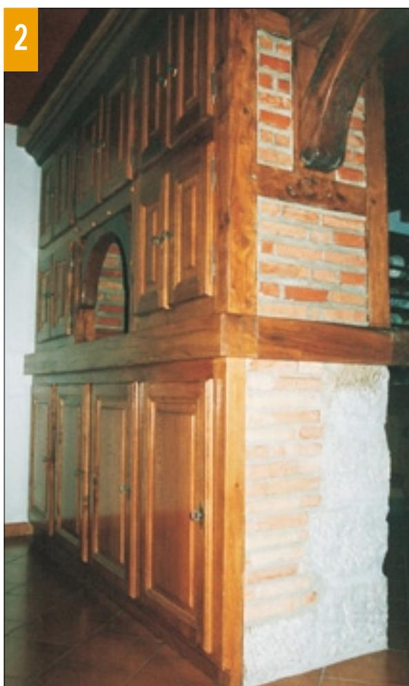
dos de la traverse inférieure. Le montant gauche est fixé au mur d'appui par vis et chevilles, tandis que le montant extérieur sera scellé dans les retours de la paroi maçonnée.
