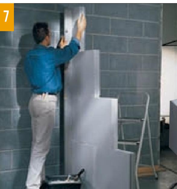
5. Ces carreaux de plâtre, montés avec une colle spécifique, s'assemblent grâce à un système de rainure et languette. En vignette, un carreau alvéolé : le poids gagné allège les cloisons.
