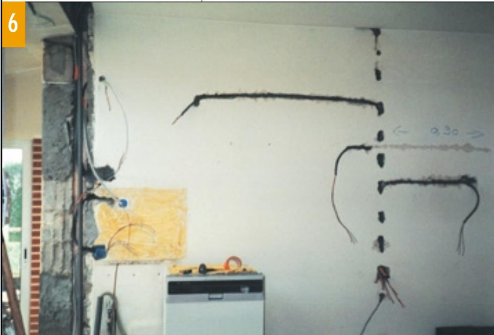
**6.** Le déplacement des éléments de la cuisine suppose une grosse modification de la plomberie - évacuations et alimentations - et des circuits électriques. Des saignées sont creusées d'un point à l'autre.
