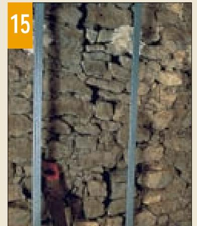
**15.** La laine de verre (ou de roche) souple est idéale pour doubler les maçonneries grossières. Maintenu par des rails verticaux supports de parement, l'isolant est déroulé avec son pare-vapeur côté chaleur. CASTORAMA
