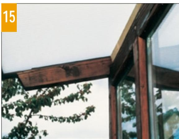
sablière de la véranda. Un clouage renforce l'assemblage. La découpe de l'entaille doit bien suivre la pente de la toiture et sa profondeur est équivalente à 1/4 ou 1/5 de l'épaisseur du chevron.
